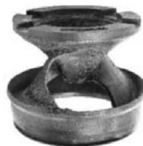
Рис.8 Типичные следы разрушения материала рабочего колеса вследствие кавитации
